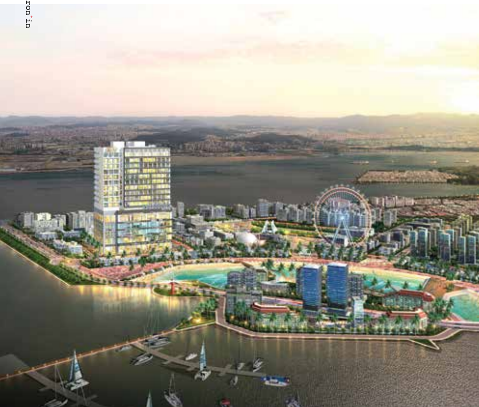
'오뷰 코스타' 완공 후 시화 MTV 거북섬 전경
